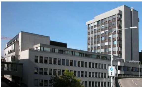
ETHZ Gebäude CHN im Turm / Zürich / 2020
