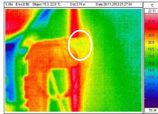
Abbildung 51: Oberflächentemperaturen Rauchrohr (Ansicht seitlich)
