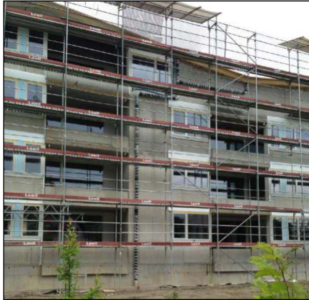
Abbildung 3: Dachabwasser im Dämmperimeter verlegt (Quelle: © OEKAG EnergyStop®)
